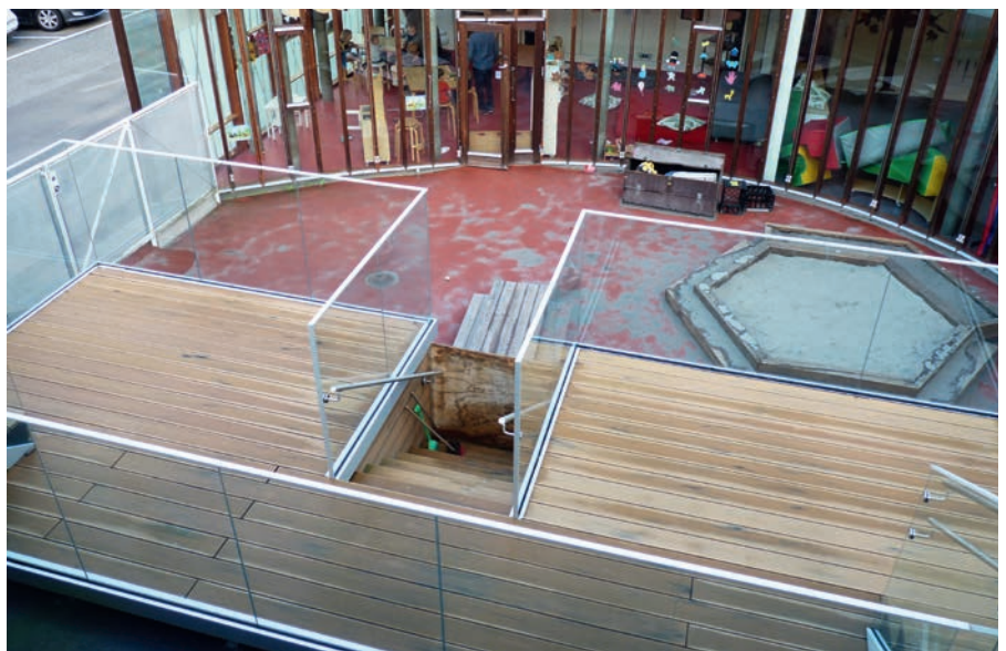
Et eksempel på sand oprydningsarbejde
